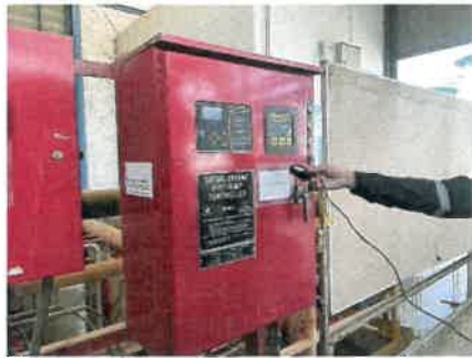
พื้นที่อาคารกรองน้ำ เฟส 1: ตู้คอนโทรลเครื่องยนต์ดับเพลิง
